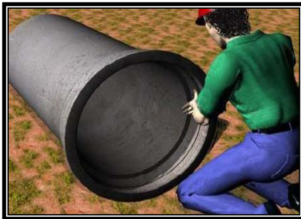
Figura 3 - Lubrificação do anel de borracha
